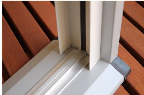
12- Montaggio guida inferiore, senza forare, pulire il pavimento, staccare il biadesivo e fissarla al centro delle guide
