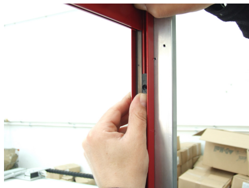
16 fissa la guida con tacchettino senza forare
