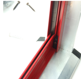
14 fissa la guida con tacchettino senza forare
