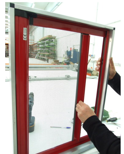
16 fissa la guida con tacchettino senza forare
