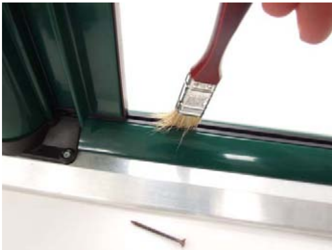
27° tenere sempre ben pulita l'interno della guida
