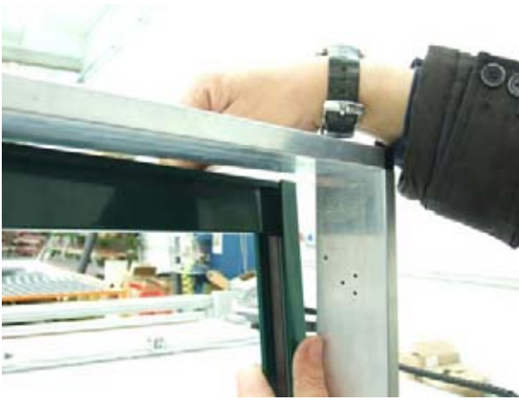
19° inserire guida superiore all'interno guida al muro
