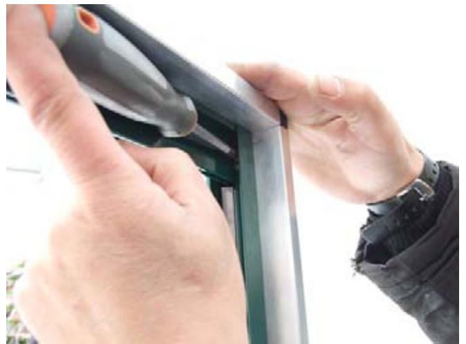
22° avvitare la vite in dotazione
