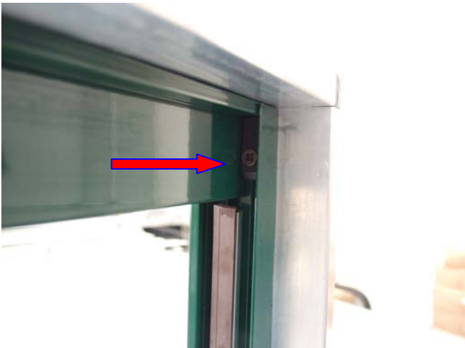
21° fissare tacchetto con vite in dotazione per blocco guida
