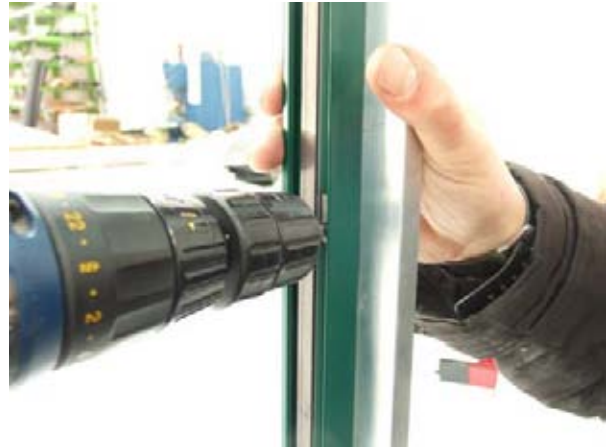
20° fissare guida a muro, nei tre punti
