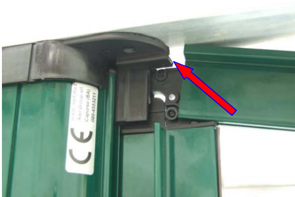
17° inserimento della guida superiore
