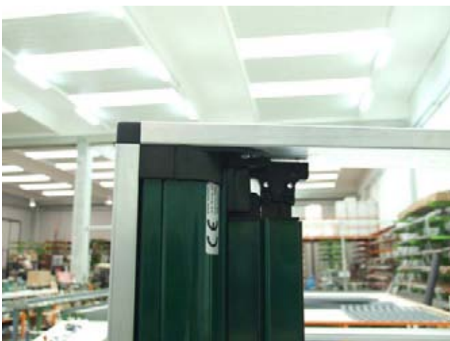
5° inserire il cassonetto, bloccare con attacco guida
