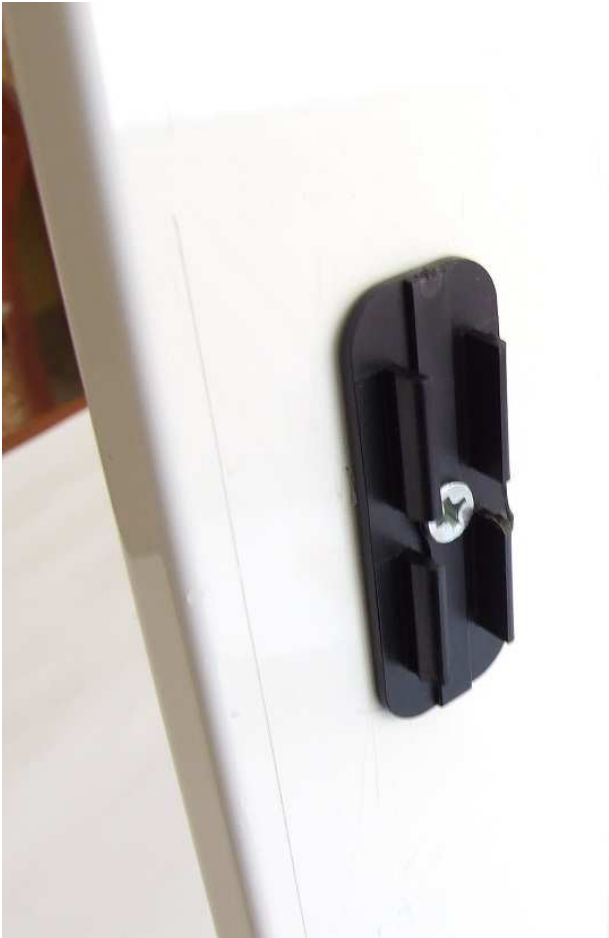
6 fissare 2 mollette a gancio per lato, per attacco zanzariera o guida frontale, il fissaggio deve'essere perpendicolare alla cuffia inferiore e superiore
