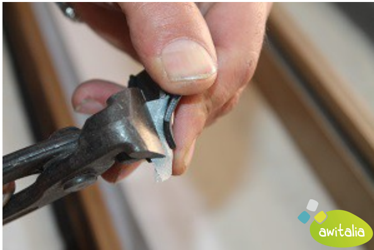
11- Strappare con la tenaglia il rivetto fissaggio rete
