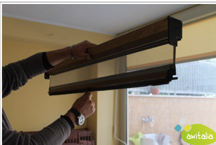
45- Prova tensione della molla caso scarica o carica
