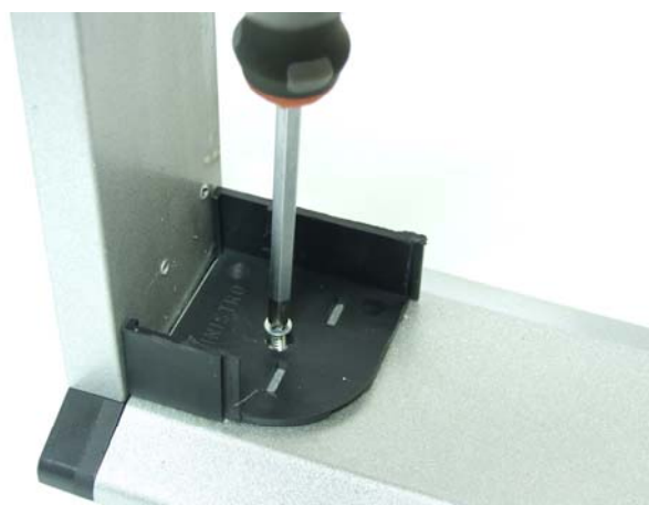
2 Fissare il copritestata dx-sx con un solo foro per lato
