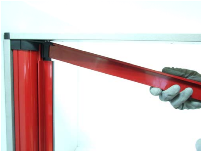
12 Inserimento guida lato superiore
